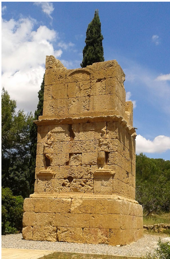
Figura 20. La llamada Torre de los Escipiones, primera mitad del siglo I (CIL II 2 /14, 2306). Foto: DAI [foto: D. Gorostidi].
