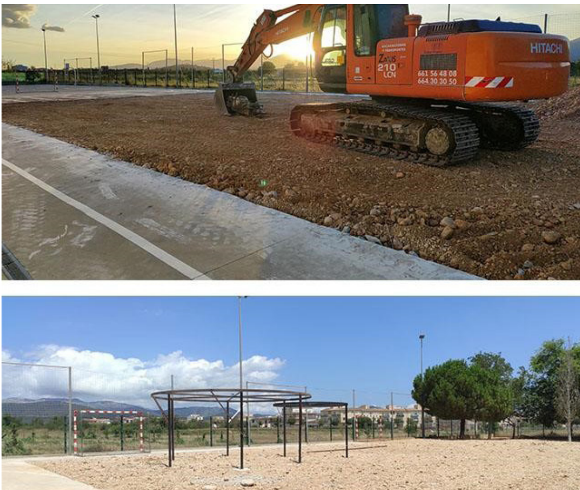
Figura 14. Proceso de repicado y construcción de las pérgolas. Fuente: autores
