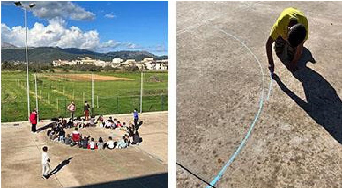
Figura 13. Proceso de replanteo del ágora y las pérgolas. Fuente: autores
